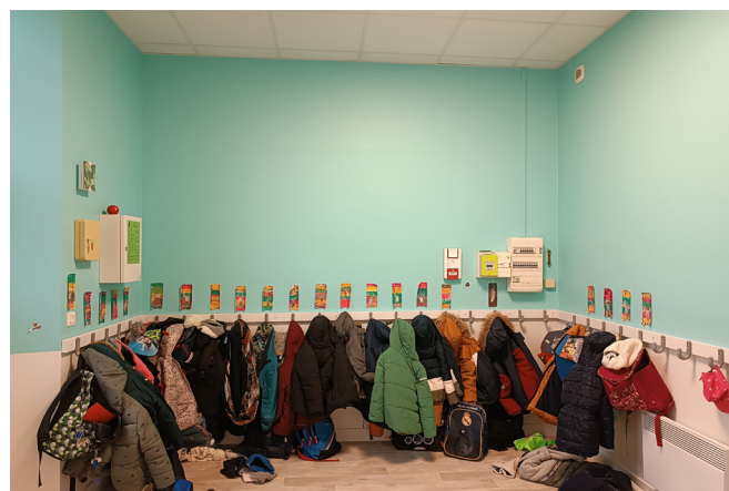
Travaux de peinture - École de Coulombiers
