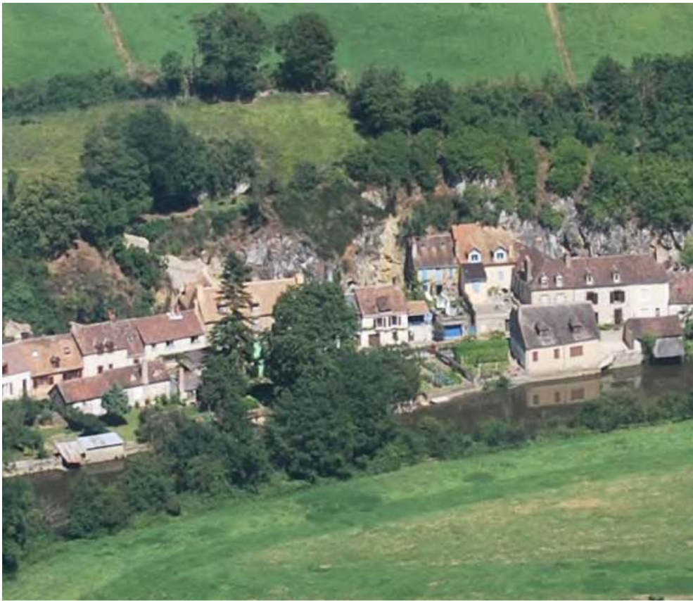
Front urbain quasi continu devant le front du coteau du bourgneuf. Étagement de quelques constructions contre le front de coteau.
