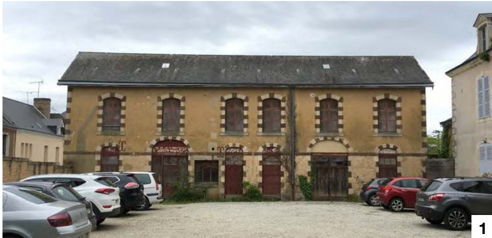
1 Entrepôt de l'Hôtel Hatton, rue Saint-Sauveur. Futur musée de la Coiffe. Le bâtiment est en partie implanté en place d'un bâtiment plus ancien (la partie droite - deux dernières travées - figure sur le cadastre de 1812).
