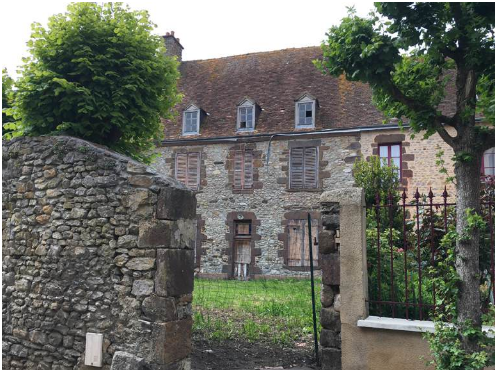
Ancien presbytère actuelle rue Hochin, (hospice et ses jardins, rue des Fossés de l'Hôpital sur plan d'alignement de 1848). La partie est seule a été restaurée. AD_72-30_910
