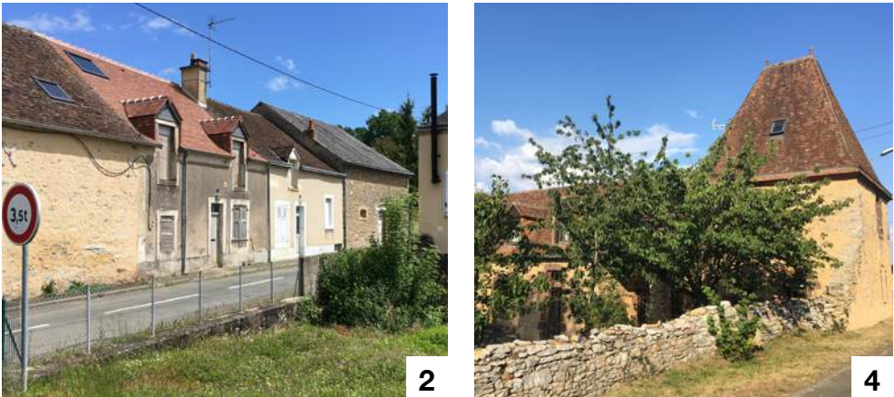
1 Au nord du Ruisseau des Torrentins, un ancien pigeonier pour une ferme constituée de plusieurs bâtiments (la Grande Arche). 2 Bâtiments en bande d'ouvriers agricoles, route de Mamers (petite rue de la Gare). 4 À Beaulieu, tour carrée d'un bâtiment implanté en hauteur, qui devait probablement constituer une cour.
